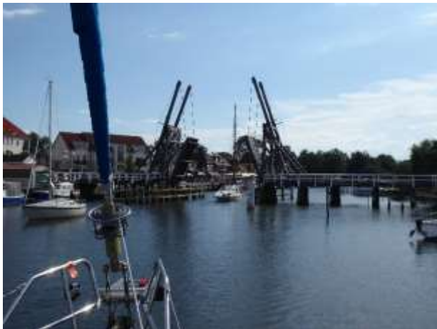
Hubbrücke in Wieck
